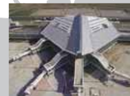
New Ulaanbaatar International Airport LLC Управление аэропортом (Монголия)
